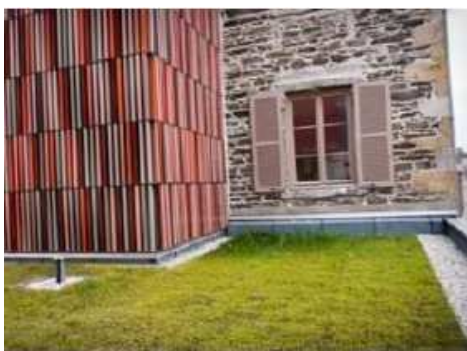
Toiture végétalisée (source : Grand Lyon)
