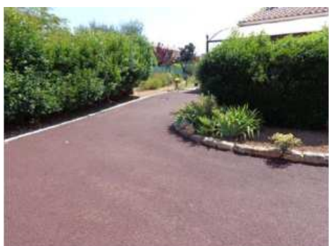
Allée/parking en enrobé poreux (source : Celtivia)
