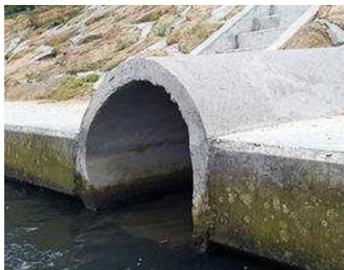
Figure 1 : Exemple de rejet d'eaux pluviales dans un cours d'eau
