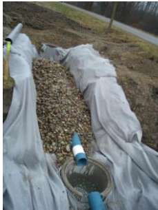
Aménagement d'une structure réservoir sous voirie
