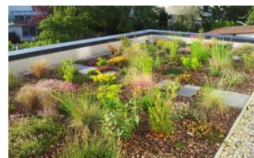
Toiture extensive composée Source : Ecovégétal
