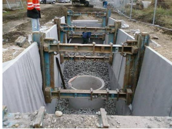
Bassin enterré en cours de réalisation
