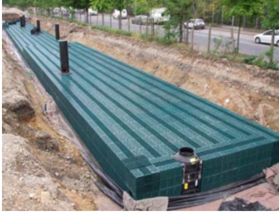
Bassin enterré à structure alvéolaire
