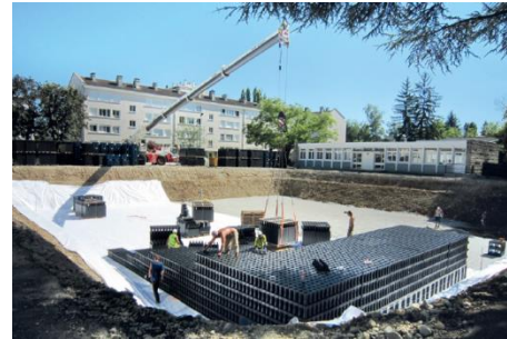
Structure réservoir alvéolaire
