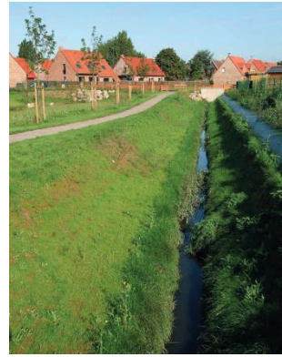
Fossé dans une ZAC
