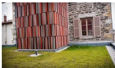
Toiture extensive simple Source : Grand Lyon
