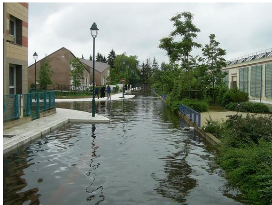
Exemple de quartier conçus de manière à limiter les conséquences d'écoulements exceptionnels
