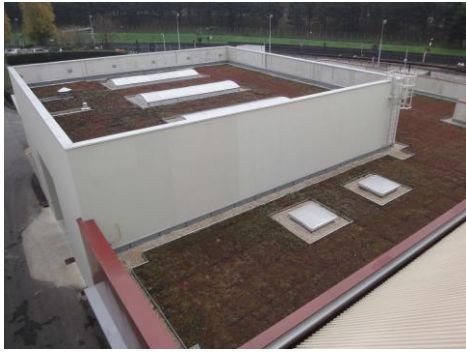
Toiture terrasse stockante
