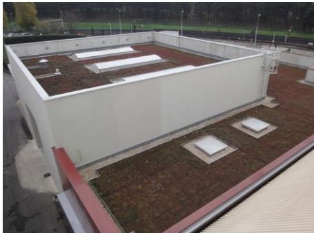
Toiture terrasse stockante
