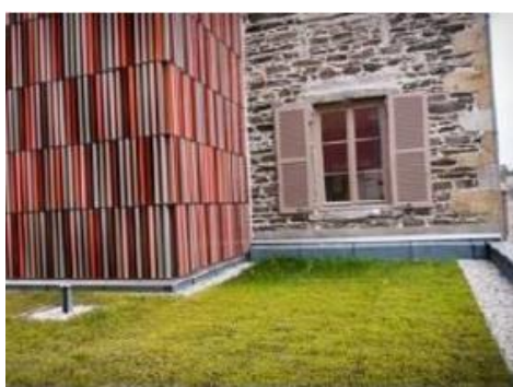
Toiture végétalisée (source : Grand Lyon)
