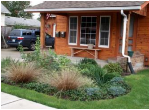
Jardin de pluie planté collectant les eaux de toiture (source : Cobamil)
