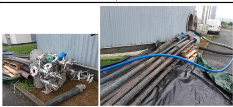
figure 4 : cannes de brassage du digesteur 1 déposée et stockées
