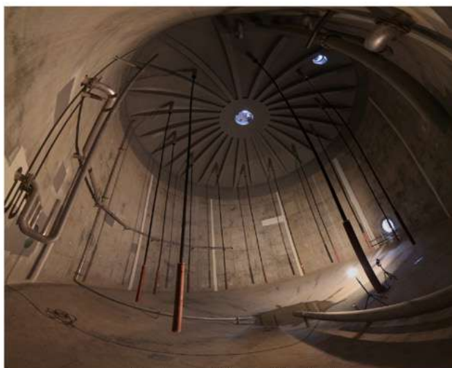
Figure 1 : cannes de brassage du Digesteur 1
